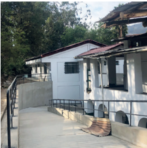
... und ein fertiges Gebäude
