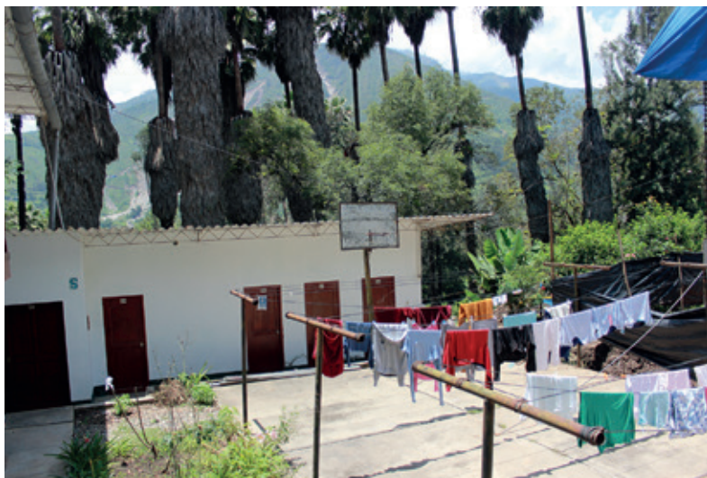
Toiletten und Waschanlage mit Wäschetrockenplatz
