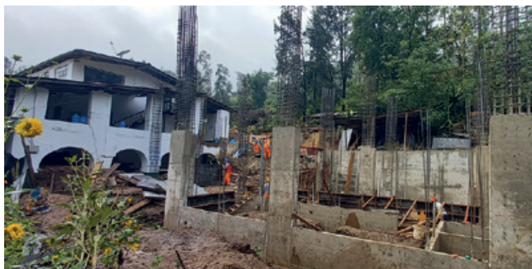
... dann entstanden Wände und Stützen ...
