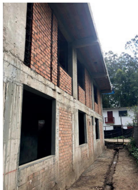
... dann ein ganzes Gebäude ...
