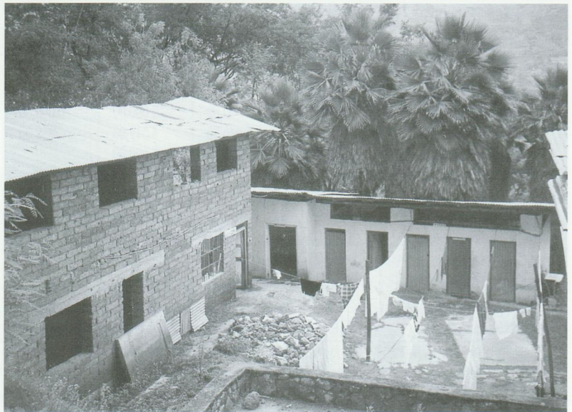
Heutiger Zustand: Wäscherei, Latrinen, Duschen, Trockenplatz
